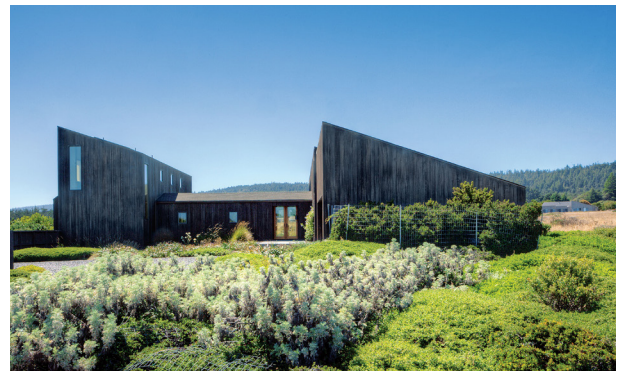
Lessenaarskap in functie van windrichting (Sea Ranch California)
